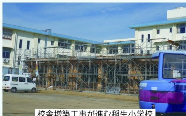
校舎増築工事が進む稲生小学校
