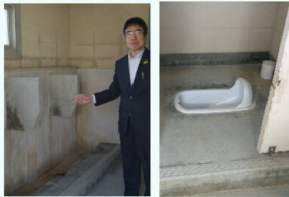
創徳中学校運動場のトイレ 昔ながらの汲み取り式便所
