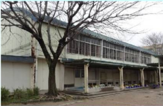
石薬師小学校体育館(1974年建設)
