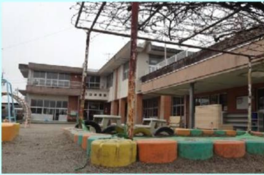
西条保育所(1978年建設)
