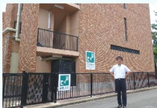
津波避難ビルとして改築された老人福祉施設
