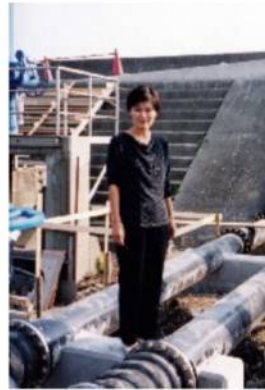
長太の排水樋門、排水機で浸水被害解消。
