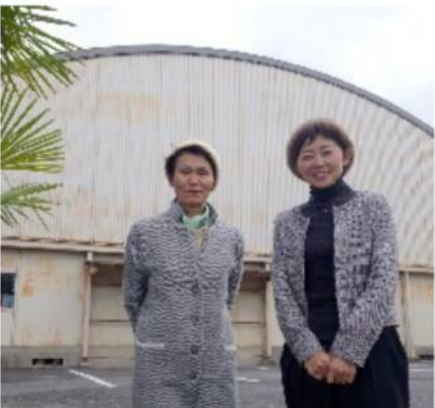
老朽化がすすむ牧田小学校屋内運動場
